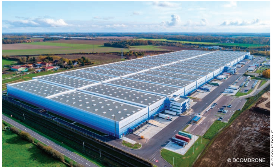
Plateforme logistique Conforama de 177 500 m 2 à Tournan-en-Brie
