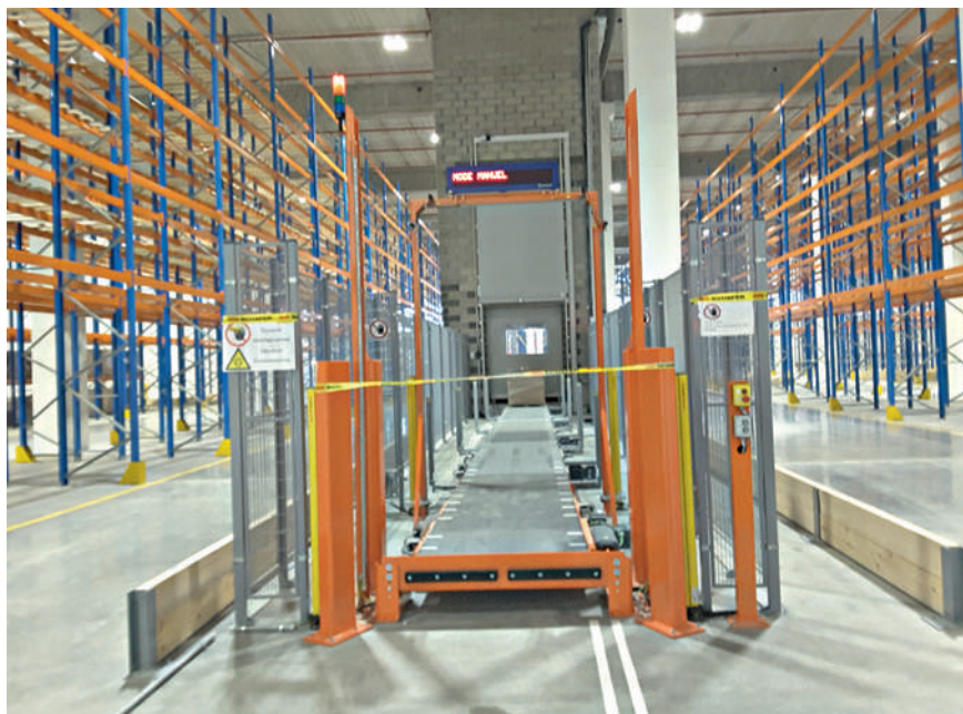
Ascenseur équipé de convoyeurs, reliant les espaces occupés par IKEA sur les deux étages de la plateforme.
