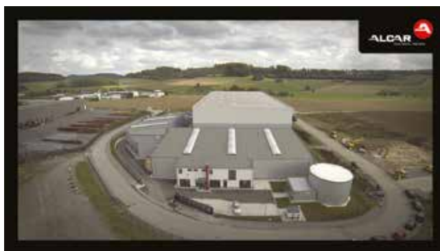
Le nouveau magasin central d'Alcar : dans un rôle d'entrepreneur général, Viastore a géré la construction, fourni la technique de stockage et assuré le volet logiciel.
