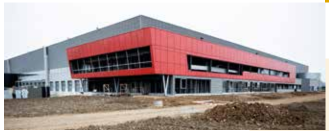
Le futur entrepôt entièrement automatisé et robotisé de 36 000 m² à Réau, près de Moissy.
